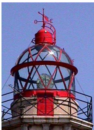
parásitos durante el giro que falseaban la característica. Por otra parte, los montantes verticales formaban zonas de sombra. Estos problemas se resolvieron utilizando linternas cilíndricas de cristales curvos y montantes helicoidales.
