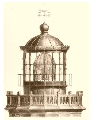
La parte superior se cerraba con una cúpula metálica, generalmente de cobre, abierta en la parte superior para que hubiera ventilación. Cuando la cubierta era transparente, una porción de luz se desviaba hacia arriba, para servir también de guía a la navegación aérea, para ello se utilizaban sistemas ópticos especiales, a este tipo de linternas se las denomina "aeromarítimas".
